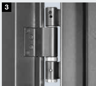
Łatwa wymiana rolek zawiasów na płycie drzwiowej
